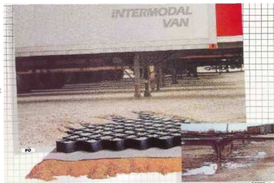
Zdj.1 Widok przed i po wzmocnieniu systemem komórkowym GEOWEB®
